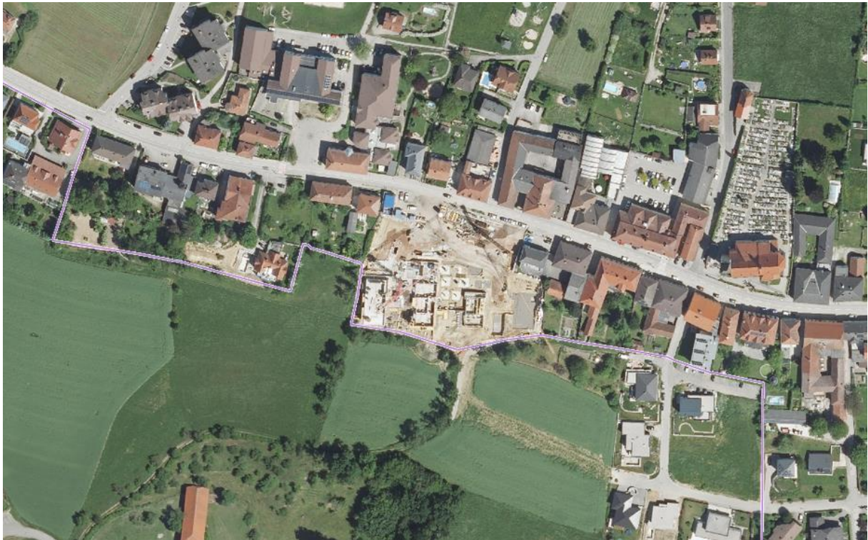
Abbildung 7: Bauprojekt zur Nachverdichtung im Ortszentrum in der Bauphase (Quelle: NÖ Atlas)
