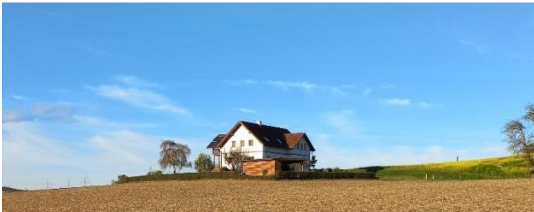
Abbildung 14: Wohnhaus ca. 320 m westlich des Geltungsbereichs
