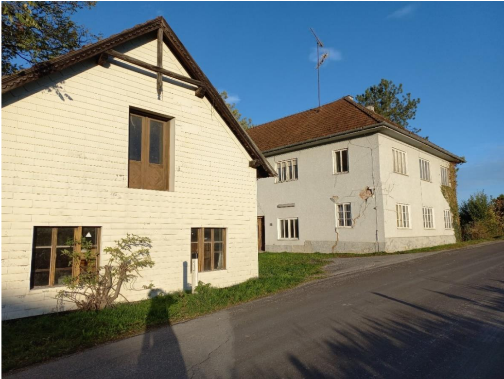
Abbildung 5: Wohngebäude (derzeit nicht bewohnt) mit Nebengebäude direkt südwestlich an den Geltungsbereich angrenzend
