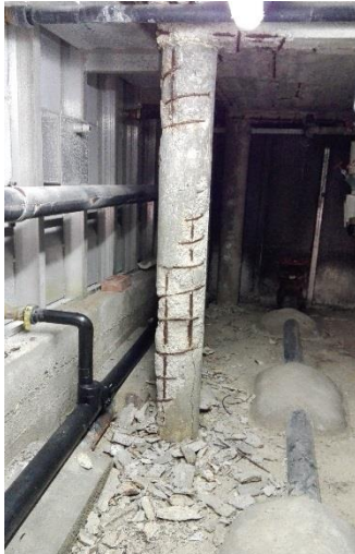
Keller des Hallenbades.
