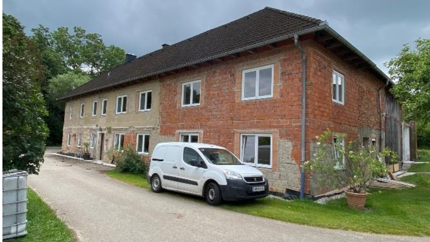
Abbildung 42: Blick auf das Gebäude welches als Geb ausgewiesen werden soll. (Quelle: Gemeinde Neuhofen/Ybbs)
