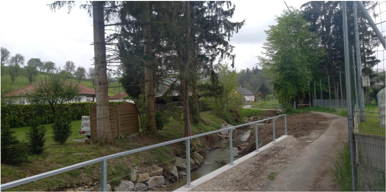
Abbildung 14: Nördlicher Teil des Weges, am Sportplatz vorbei
