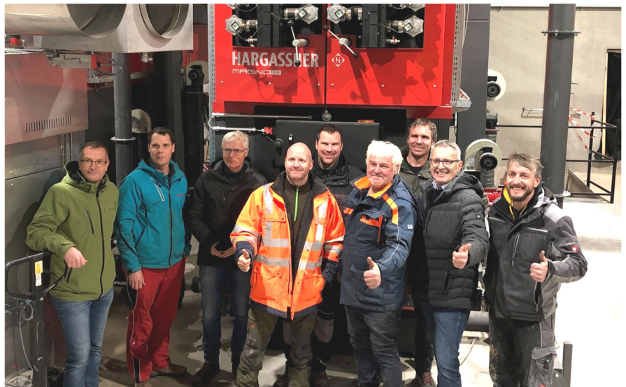
Der Mitarbeiter der Fa. Ringhofer & Partner, die Mitglieder der NWG-Nahwärmeversorgung Lunz am See mit ihrem Obmann Karl Pechhacker, Bgm. Josef Schachner und Heizwart Franz Heigl freuen sich über die erfolgreiche Inbetriebnahme des neuen Heizwerkes.
