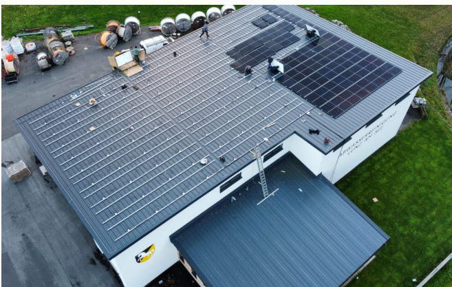
Die Photovoltaikanlage auf dem Dach der Kläranlage wurde noch im November durch die Firma KraftCom montiert.
