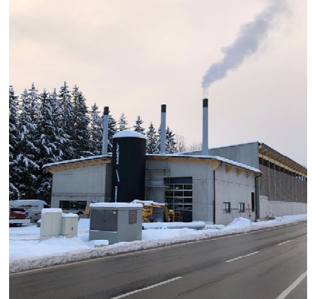
Am Montag, 4. Dezember 2023 stieg vom neuen Heizwerk nach dem Probeheizen erstmals der weiße Rauch auf.
