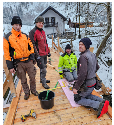
Die Mitarbeiter der Firma Heigl bei den Arbeiten zur Erneuerung der Brücke.
