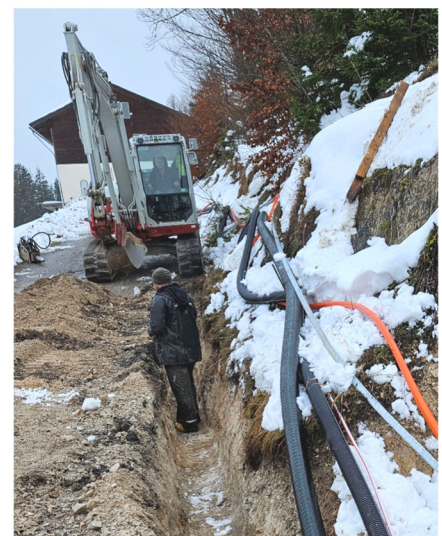
Die Grabarbeiten gehen auch bei schlechteren Wetterverhältnissen unvermindert weiter.
