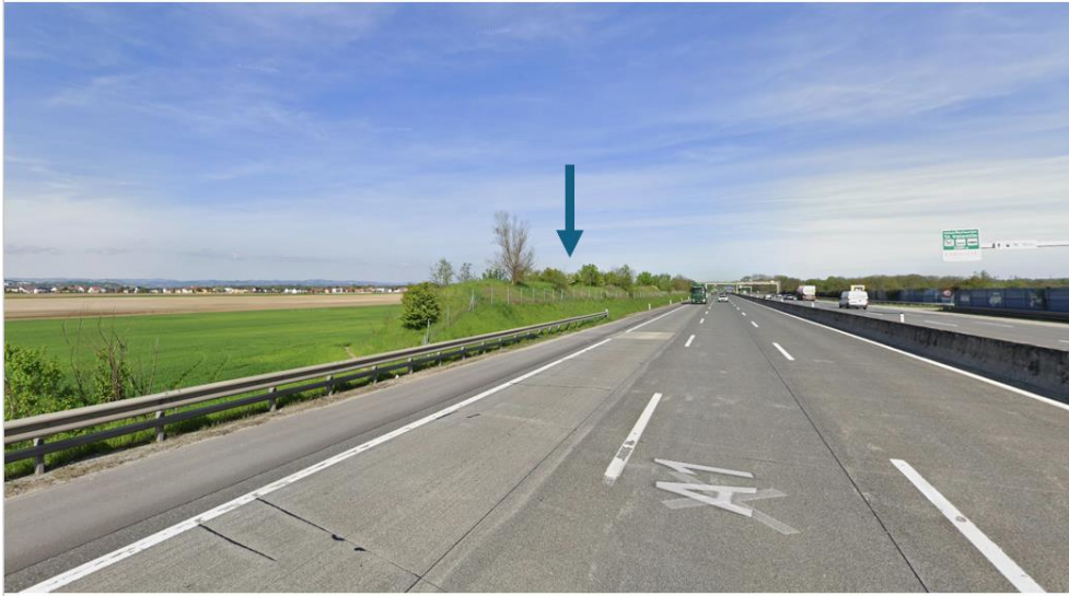
Abbildung 10: Blickbeziehung mit der A1 (Westautobahn)
