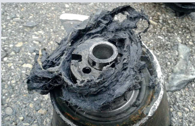
Foto: So können Feuchttücher, Binden, Fetzen, Tampons,... die Pumpen in der Kläranlage verstopfen!
