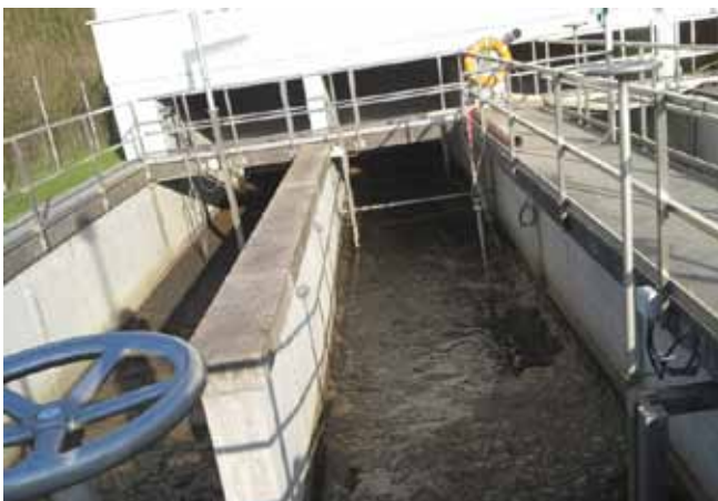
Foto: Die Kläranlage Ardagger reinigt täglich die Abwässer von rund 800 Häusern.
