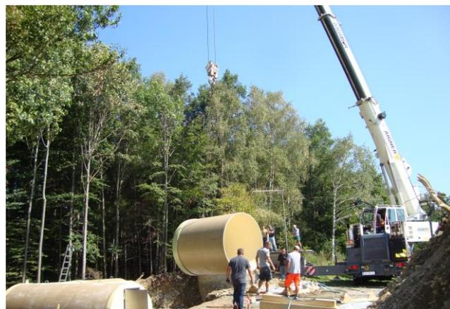
Die Wasserversorgungsanlage wurde im Bereich Hoferkogel erweitert. Um die Versorgung in den Bereichen Badhof und Sträußl auch weiterhin sicherstellen zu können, wurde die Kapazität durch neue GFK-Kunststoff-Behälter von 30 auf 60 m<sup>3</sup> erhöht.
